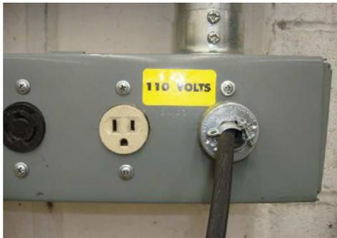
**1** Conectar equipo a toma de corriente de 110 volts.
